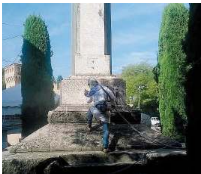
PULIZIA I tecnici all'opera per eliminare le scritte dal monumento dei caduti
